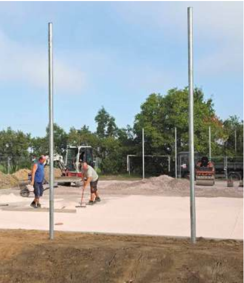
Výstavba hřiště v Okružní
