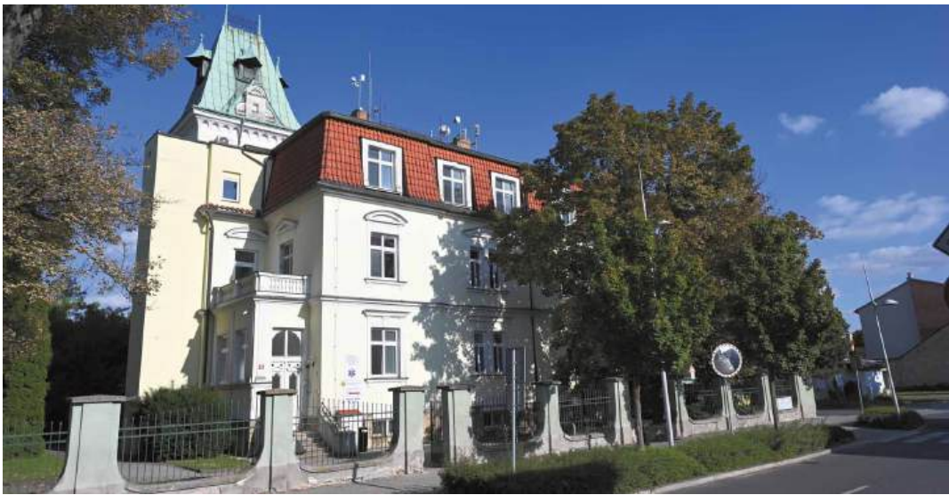
Ve Vichrově vile jsme zrekonstruovali společné prostory
