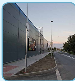
Rekonstrukce komunikace Obchodní (Průmyslová)
