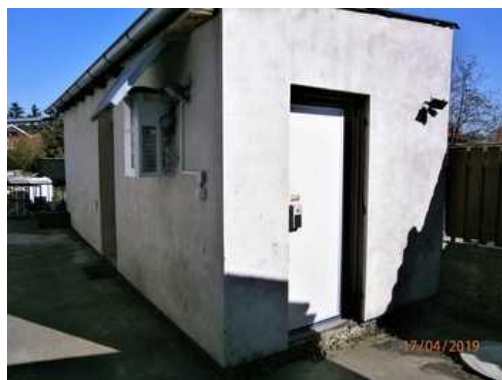
50. Samostatná budova autonomní chladírny , na SV okraji par. č. st. 43/1.
