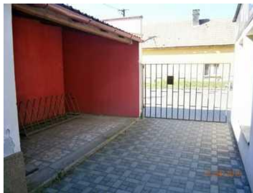
32. Pohled od V strany na vstupní vrata do areálu, vlevo krytý přístřešek na uložení kol klientů a pro bezpečnost možných ztrát.. Opět zámková dlažba vnitřních prostor dvora.
