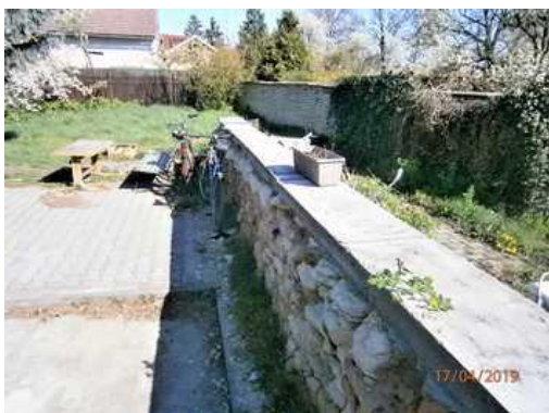
9. Pohled od JV strany na část přístupu cesty k RD s kamenou vnitřní zíd'kou, v pozadí část zahrady.
