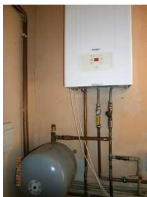
45. Technické zázemí se soustavou kotle Panther
