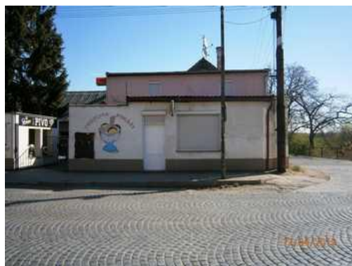
4. Pohled od Z strany z ul. Jiráskova na prodejnu, vlevo vstup do areálu s č.p. 6 a dále s č.p. 80.
