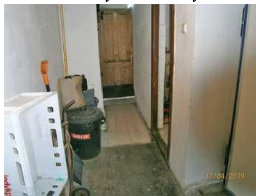
48. Pohled do technických prostor z kuchyně.
