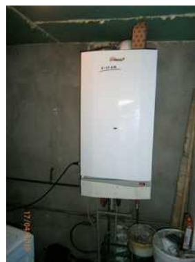
12. Pohled na technickou místnost v přízemí RD.
