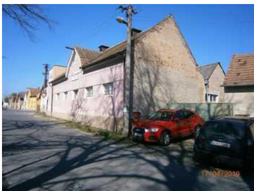
1. Pohled od V strany naboční průčelí z ul. Na Brůdku na část restaurace DALLAS.
