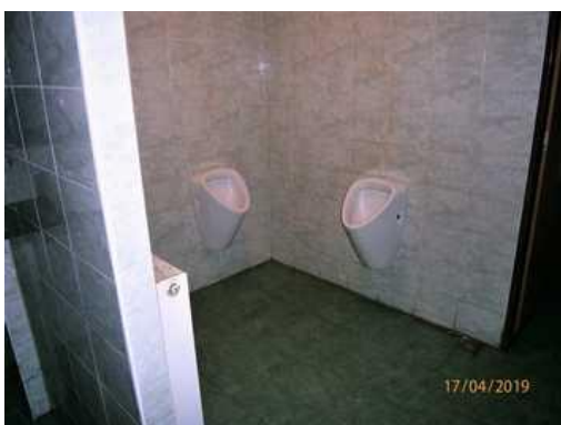
37. Pohled na pisoáry.
