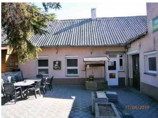
25. Pohled od JZ od vstupu do vnitřního areálu "dvora" s možností posezení a konzumace v upraveném prostředí. V pozadí stavba s kuchyní, vpravo vstup do restaurace. Vnitřní plochy s dlažbou zámkovou.
