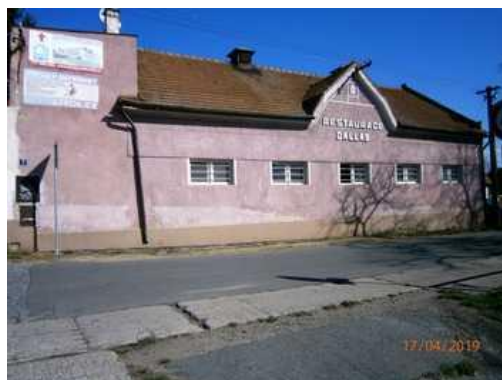
2. Bližší pohled na průčelí od J strany z ul. Na Brůdku.
