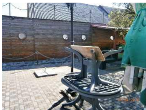
28. Pohled od JZ na vnitřní plochu k posezení, v pozadí "krycí stěna", provedená jako lodní palubu s okny, za kterou je ukryt RD.
